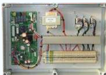
Geopende DX besturingskast.
